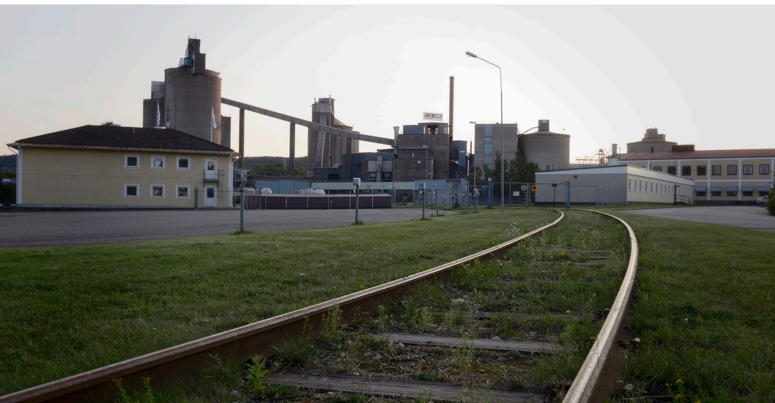
Skövdefabriken 2014. Foto: MW.
