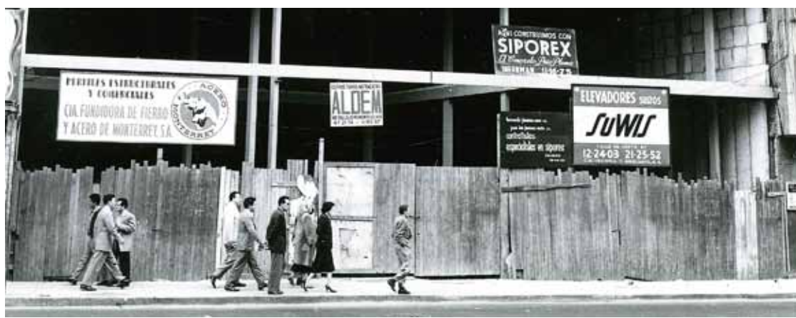
10-våningars kontorshus Mexico D.F.
